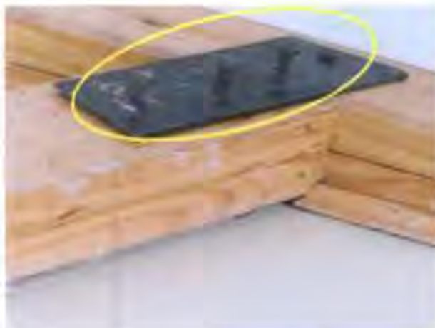
Fotografía N° 14: Detalle de fijación existente en encuentro de vigas.
